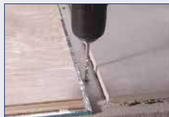
1- Avant la pose du revêtement, tracer une ligne et percer le nombre de trous souhaités (5/m) en utilisant un forêt de Ø 6 mm.
