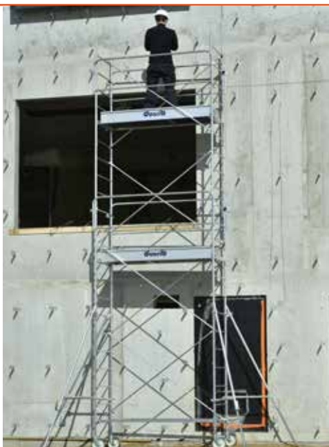
AC200 : Hauteur plancher 5,10 m soit 7,10 m Haut.travail
