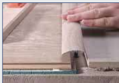
3- Le revêtement posé, positionner les chevilles devant les trous.
